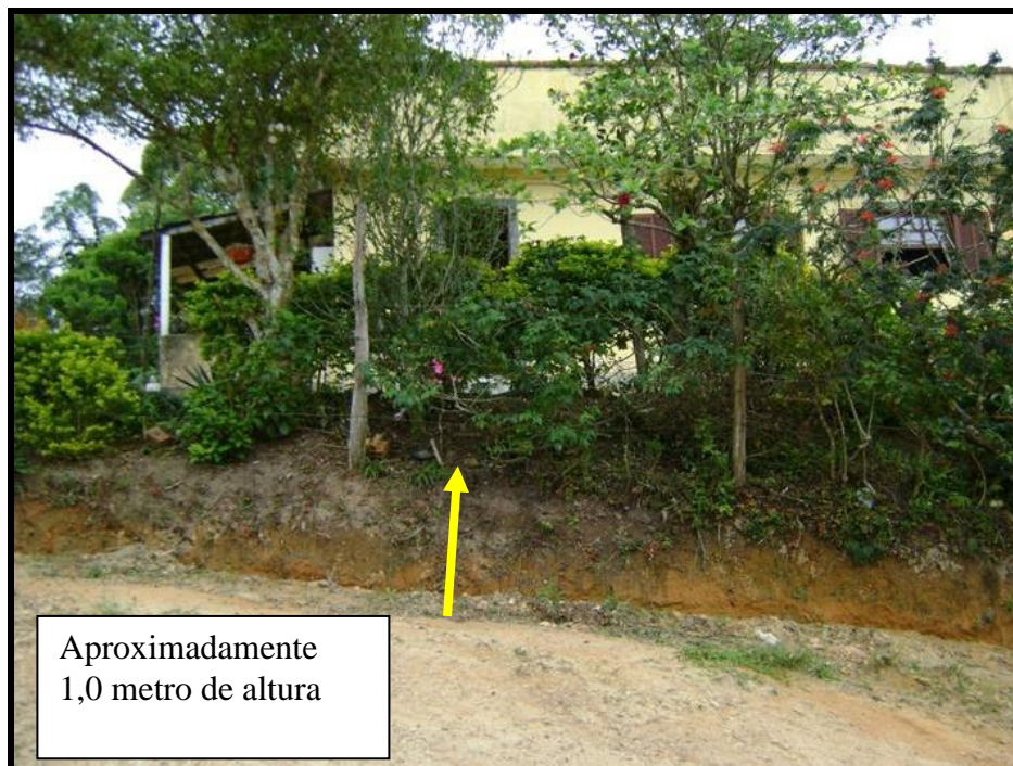
Figura 26: Aterro colocado pela população no início da ocupação dessa localidade. Atualmente essa diferença de altura vem aumentando devido à erosão do sopé desse pequeno corte. Foto F. S. Lima.
