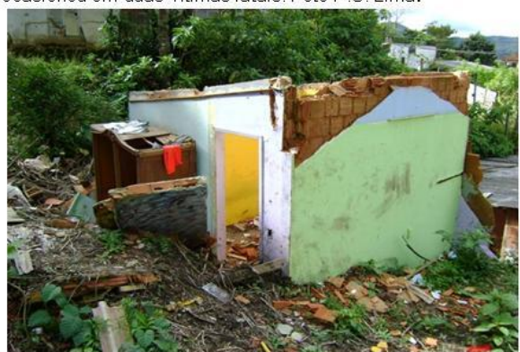
Figura 5: Detalhe da casa atingida pelo deslizamento de terra. Casa construída sob depósito de tálus. Foto F.S. Lima.
