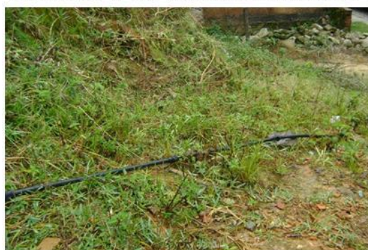
Figura 9. Detalhe de cano de abastecimento ilegal de água. Notar os remendos com fita isolante nos canos, e o constante vazamento de água. Foto F. S. Lima.
