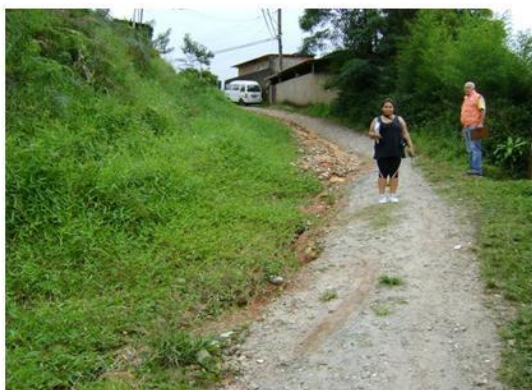
Figura 17: Acesso ao início da Rua Minas Gerais – parte 3. Observe o estado da via por onde passam pedestres e alguns Veículos. Presença de ravinamento. Foto: F.S.Lima
